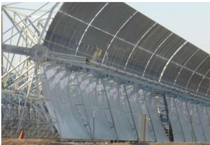
4 – сурет – Параболалық шоғырландырғышты қолданатын КЭС
